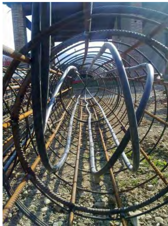
Circuito chiuso sfruttando i pali di fondazione
