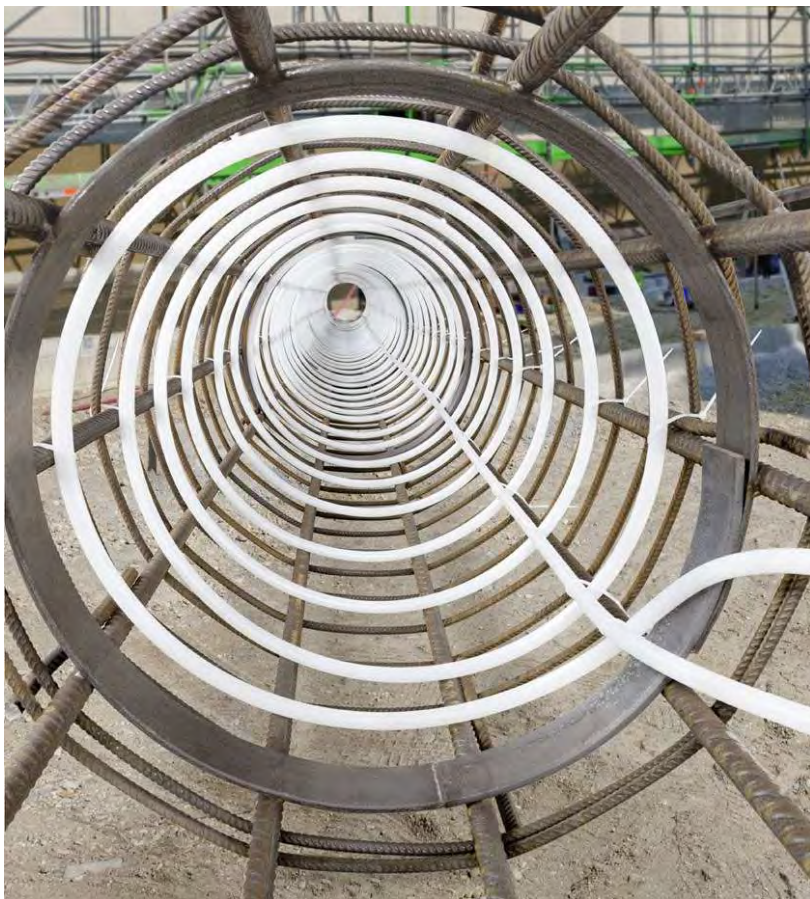
Circuito chiuso sfruttando i pali di fondazione
