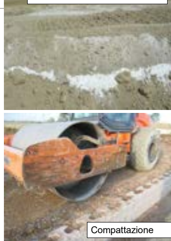
Terreno stabilizzato a calce
