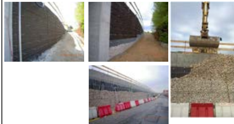
Ricostruzione e messa in sicurezza di versanti in frana con terre rinforzate
