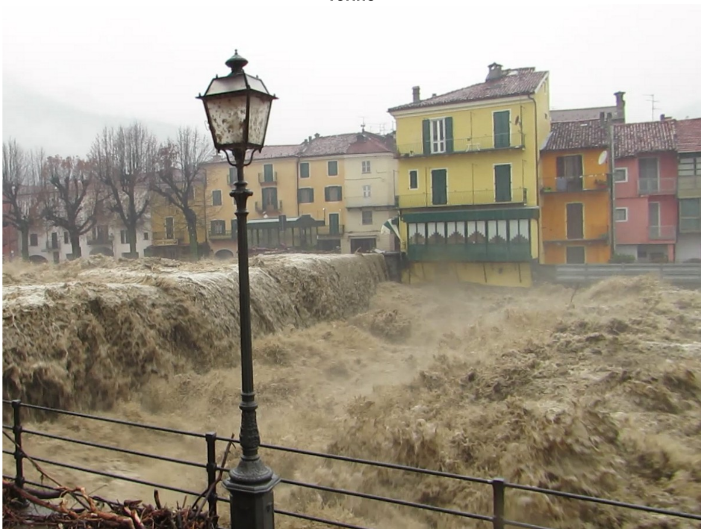
Evento alluvionale novembre 2016: la piena del Tanaro a Garessio (CN) sormonta il vecchio Ponte Odasso, attualmente sostituito da un ponte a campata unica progettato da Carlo Giugiaro - (Foto: Dott. Geol. Aldo Acquarone)
